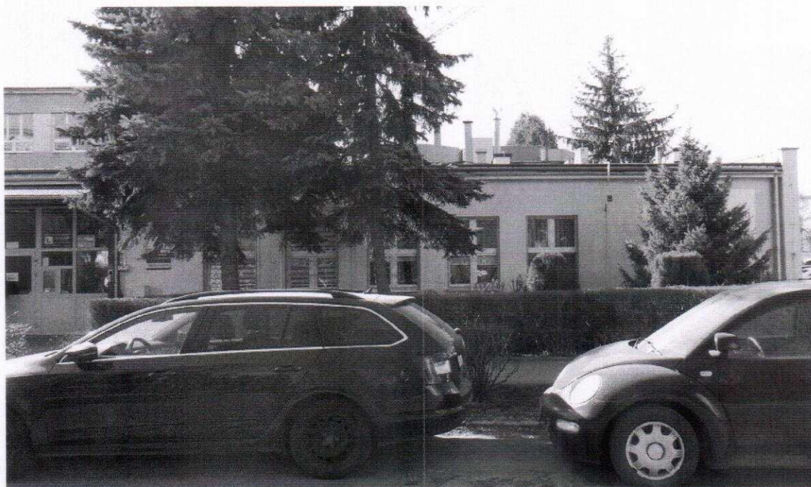
Fot. 11. Kraków, ul. Krasickiego 34, elewacja wschodnia.
