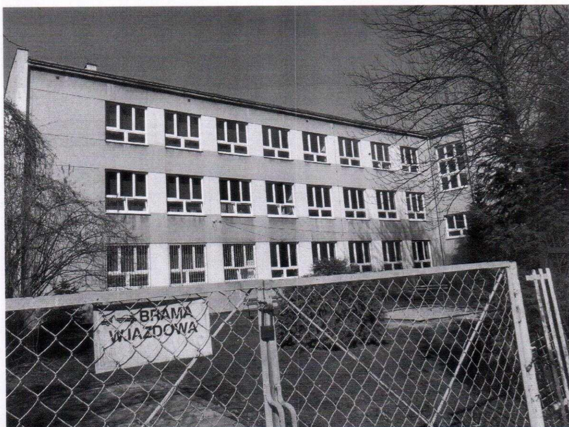
Fot. 3. Kraków, ul. Krasickiego 34, elewacja wschodnia i południowa.
