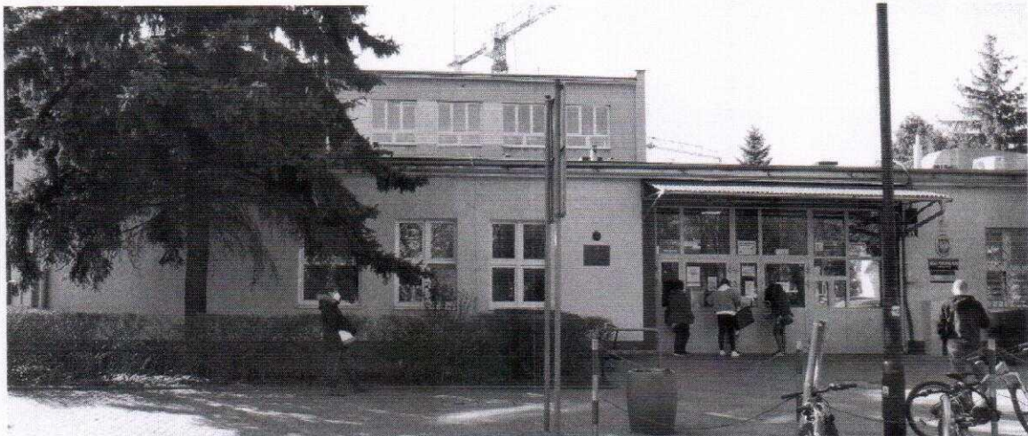
Fot. 10. Kraków, ul. Krasickiego 34, elewacja wschodnia.
