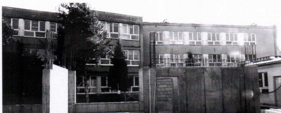
Fot. 20. Kraków, ul. Krasickiego 34, elewacja zachodnia.
