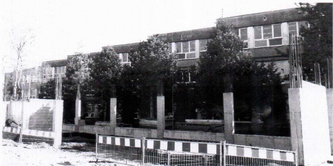
Fot. 18. Kraków, ul. Krasickiego 34, elewacja zachodnia.
