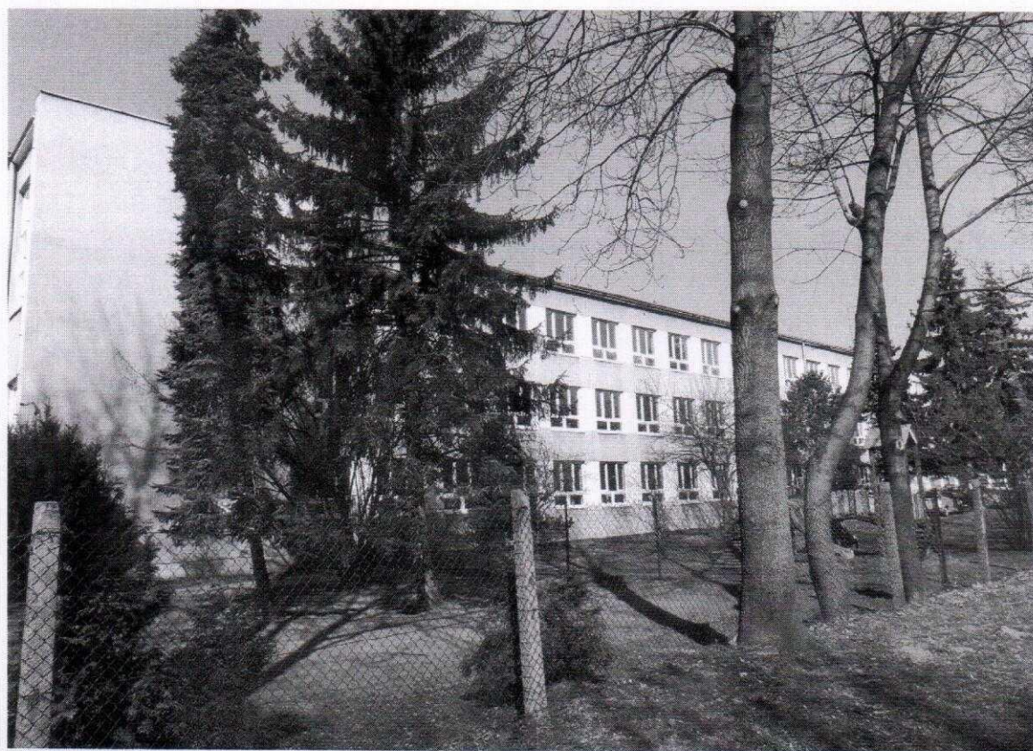
Fot. 5. Kraków, ul. Krasickiego 34, elewacja wschodnia.
