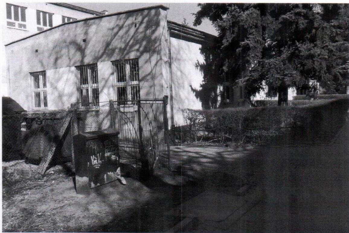
Fot. 9. Kraków, ul. Krasickiego 34, elewacja południowa i wschodnia.
