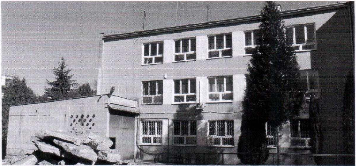
Fot. 16. Kraków, ul. Krasickiego 34, elewacja zachodnia, południowa i zachodnia.
