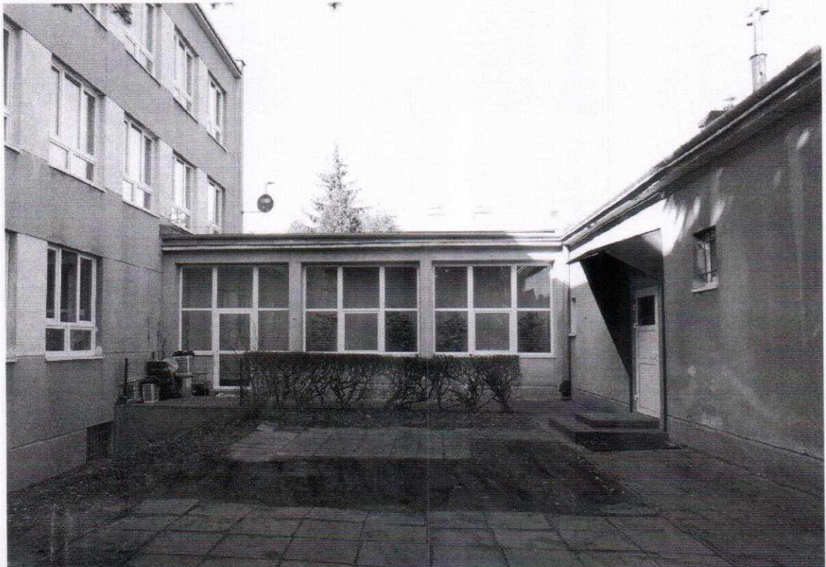
Fot. 7. Kraków, ul. Krasickiego 34, elewacja wschodnia, południowa i zachodnia.
