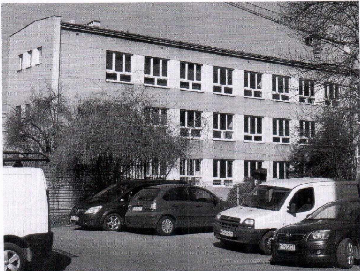
Fot. 2. Kraków, ul. Krasickiego 34, elewacja południowa i wschodnia.
