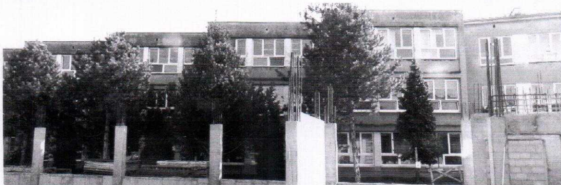
Fot. 19. Kraków, ul. Krasickiego 34, elewacja zachodnia.
